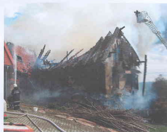
Das Wohngebäude brannte zur Gänze ab.
